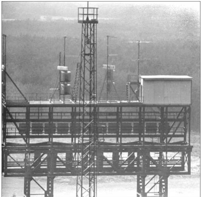
Die so genannte Funkgitterbrücke beherbergte die Technik zum Anzapfen der Richtfunkverbindungen.
